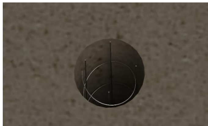
Figura 4 - Armação deve ficar nivelada com o solo
